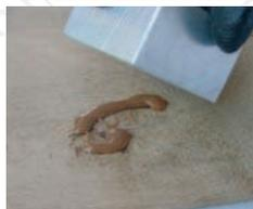
Posicionar la placa de enfriamiento sobre Knot Filler luego de inyectarlo. Para orificios irregulares de pequeñas dimensiones, se aconseja dar un golpe enérgico para hacer llegar Knot Filler a todos los espacios de la cavidad.
